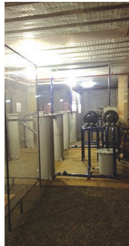
Imagem real do sistema de extração de gases, em funcionamento na área
