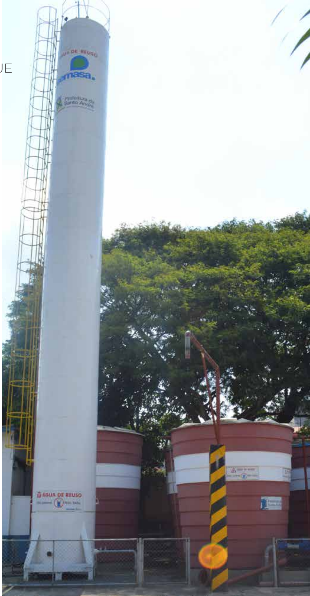
RESERVA DE ÁGUA DE REÚSO É DE 170 MIL LITROS
